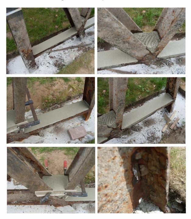
Die unteren Teile der Wehrböcke waren 100 Jahre lang dem Allerwasser ausgesetzt, welches sichtbare Spuren hinterlassen hat. Um ein weiteres Rosten der Wehrböcke zu verhindern, wurden die kritischen Flächen mit Beton verfüllt. Durch diese Maßnahme wird die Ansammlung von Wasser und Schmutz verhindert. An den Knotenpunkten sind die Stahlprofile stellenweise schon durchgerostet. Die durchgerosteten Stellen werden mit Polyesterspachtel repariert.
